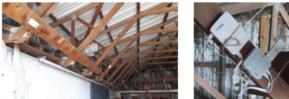
Figure 4. Site M000. Vue d'ensemble (à gauche), passerelle (à droite)
